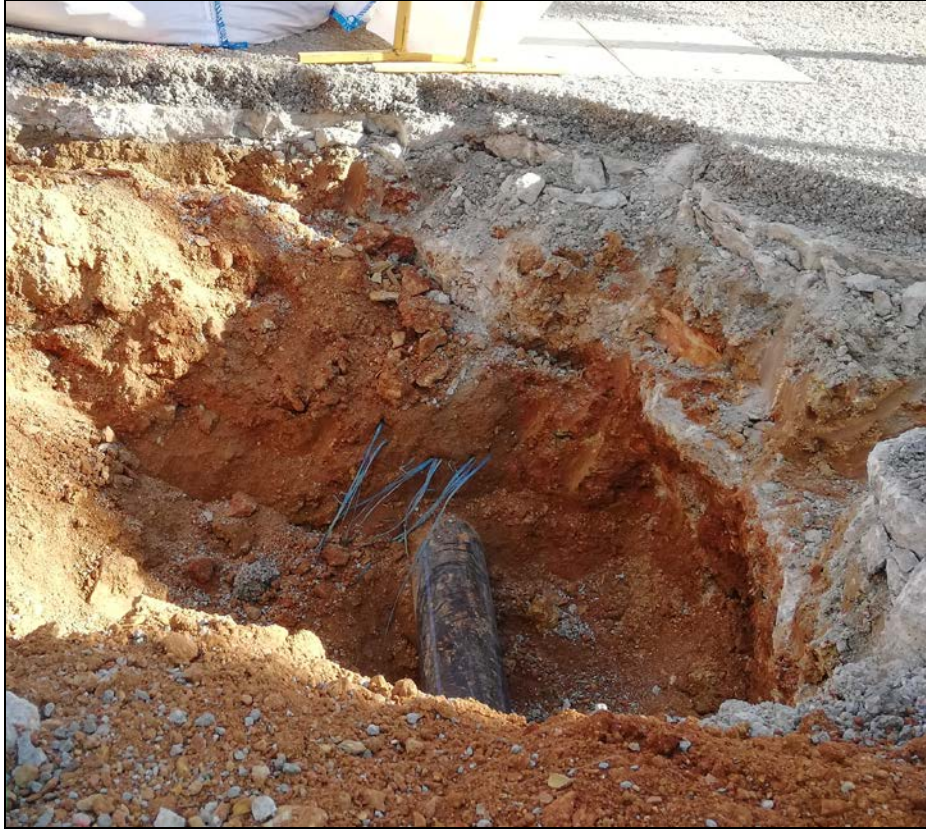
Fotografia 12: Vista de la secció del sondeig inicial de la Rasa 1000, en la que s'observa la UE 102 (formigó), 103 (sauló amb serveis) i 104 (argiles vermelles)
