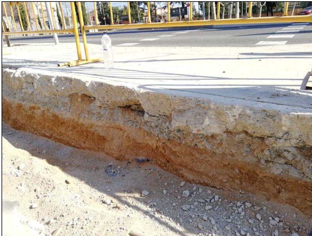
Fotografia 11: Secció tram sud de la Rasa 1000, en la que s'observa UE 102 (formigó) i UE 103 (argiles vermelles)
