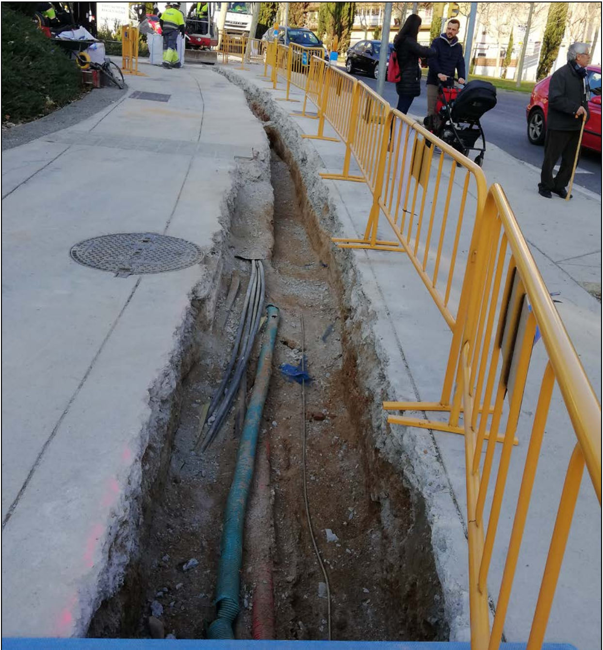
Fotografia 9: Vista de l'estrat de sauló (UE 103) amb diversos serveis de la Rasa 1000
