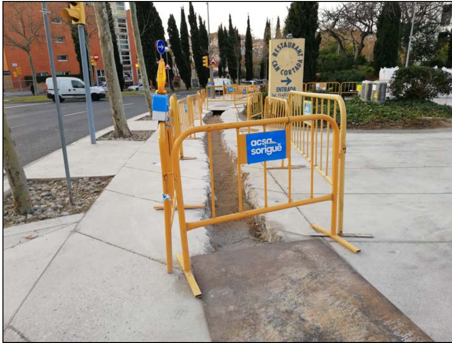
Fotografia 1: Vista de la localització de la Rasa 1000, al costat de la Masia de Can Cortada
