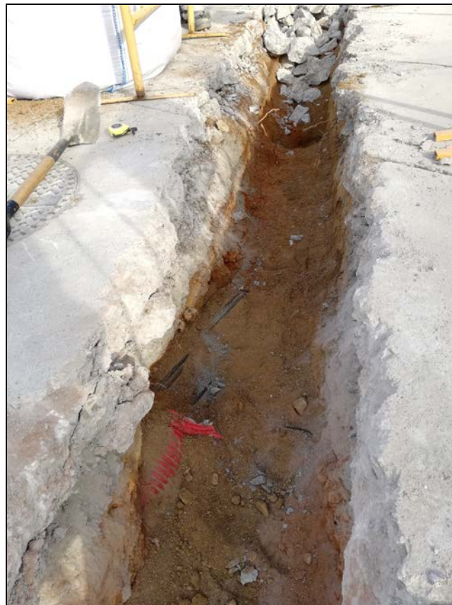
Fotografia 8: Detall de la UE 103, constituïda per sauló amb tubs de serveis
