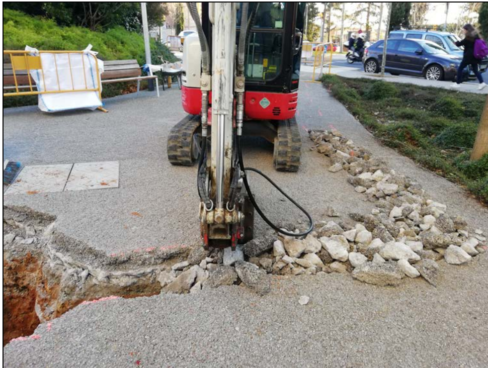
Fotografia 3: Treballs inicials d'obertura de la Rasa 1000: rebaix del formigó
