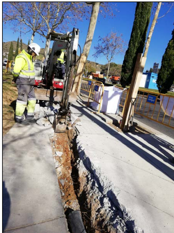
Fotografia 4: Vista dels treballs d'obertura de la Rasa 1000 amb màquina retroexcavadora tipus Bobcat
